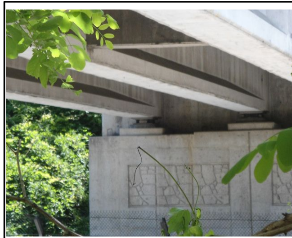
바닥판하면 및 거더 전경
